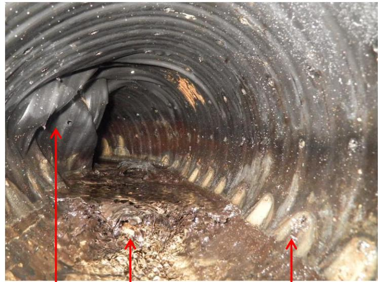
土圧に耐えられるはずのコルゲート管が変形し破壊されている
