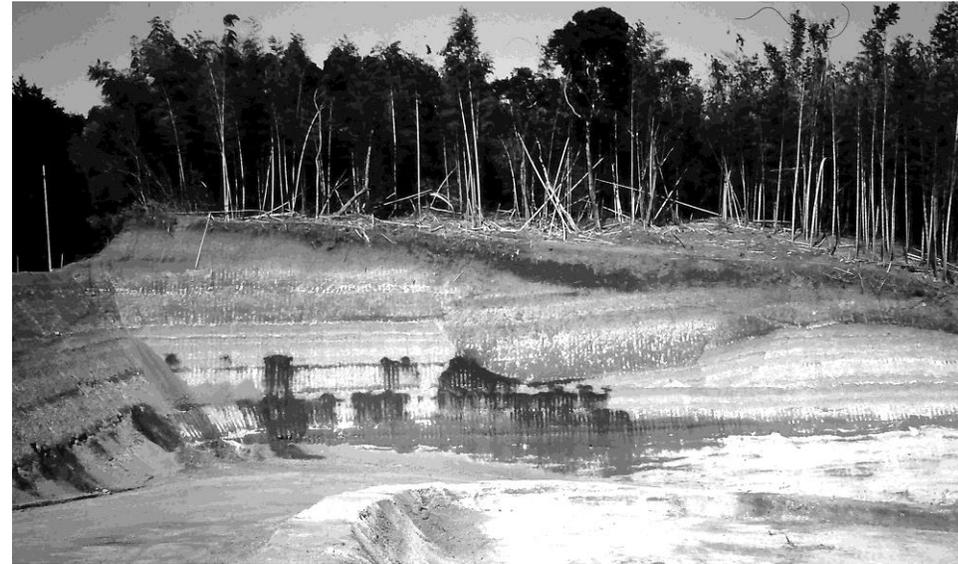
A: 崩壊した斜面に残されていた多数の「**パイプ**」（矢印）。豪雨時にパイプ孔から噴き出した高圧の地下水が、前面の土層を押し出したと考えられる。2008年7月には、ここから始まった土石流が神戸市灘区篠原台に流入した。
