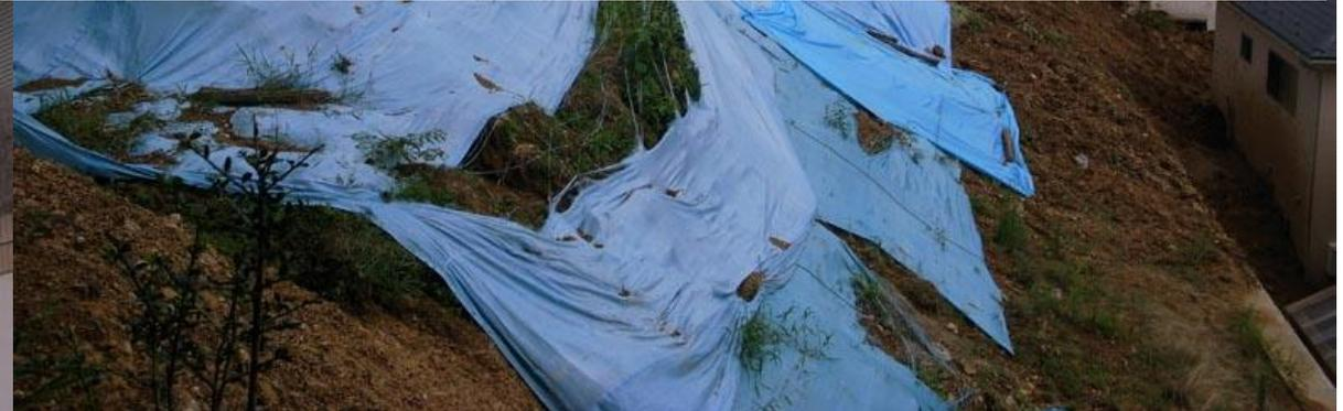
高位段丘礫層（クサリ礫層）の切り土斜面が豪雨によって崩壊し、土砂が住宅を倒壊させた。もともと礫層に大量に含まれる地下水が、豪雨によって押し出される様に切り土斜面に噴出（パイプ流）、その水圧で地表付近の土砂が吹き飛ばされた。
