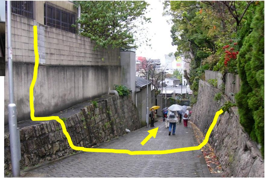
建物の亀裂は、塀に連続し、道路を横断している。右手の神社内には1995年の震災遺構（真新しい鳥居、変形した石灯籠）。
