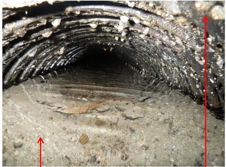
断面の7割程度が土砂で閉塞（排水機能は停止寸前）
